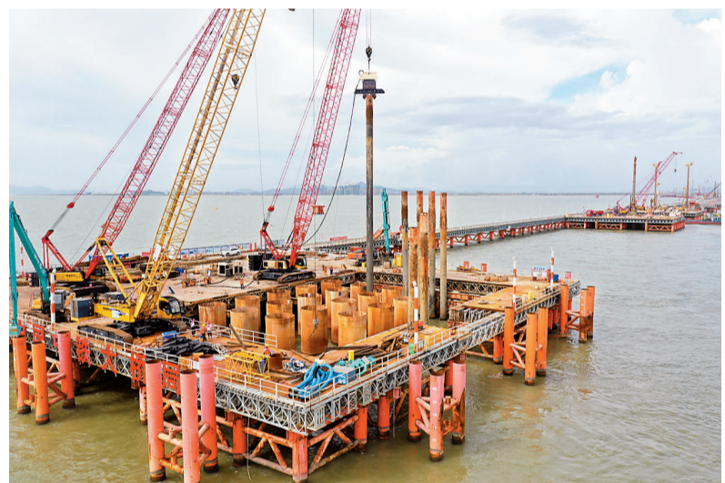
6月14日，高栏港大桥西塔主墩桩基已经完工。 本报记者 曾摄
