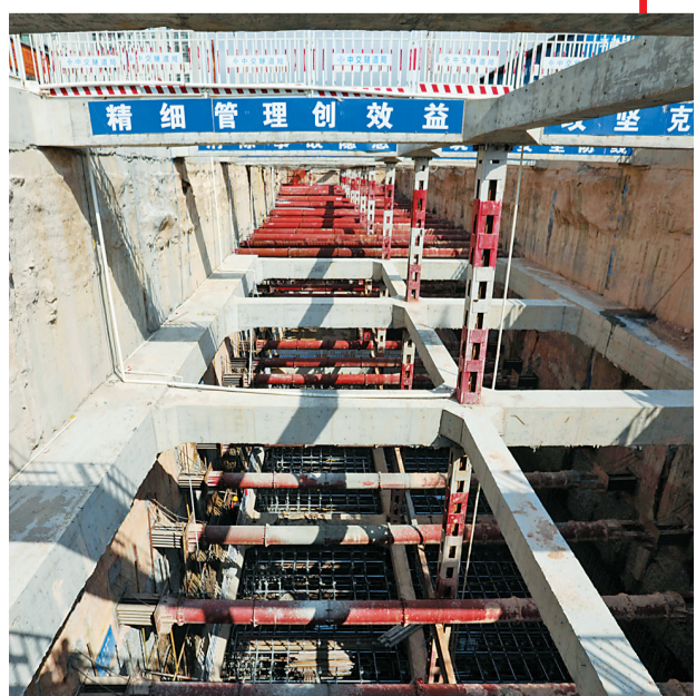
兴业快线南段施工现场。
