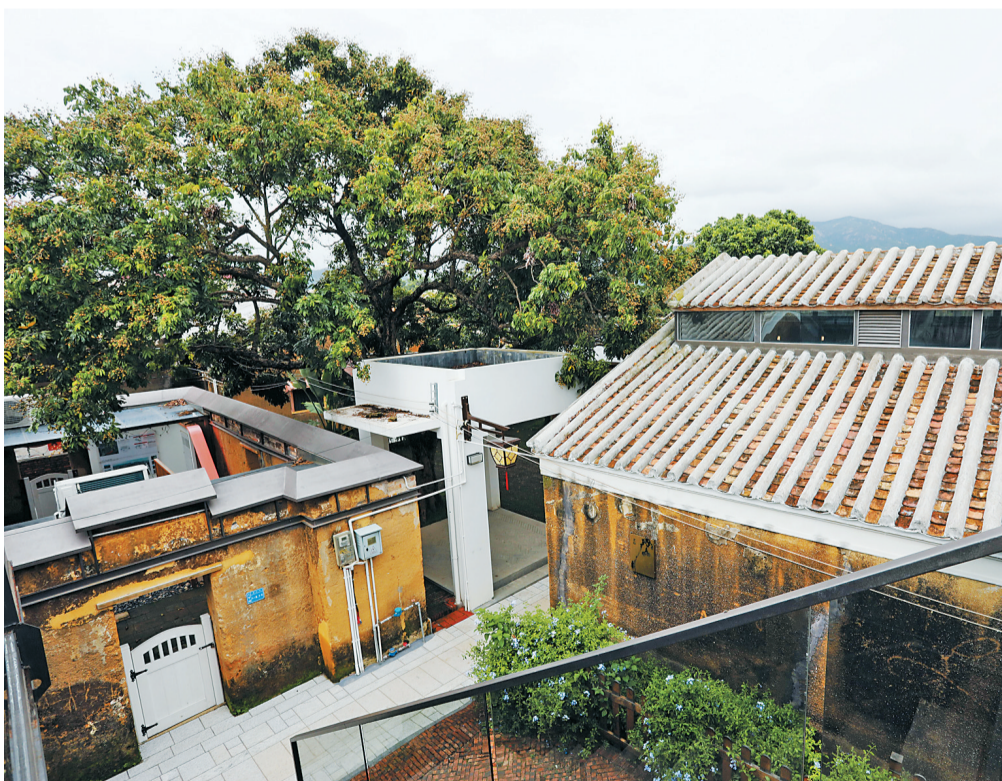
斗门区排山村巷道重新铺设,整齐美观。
