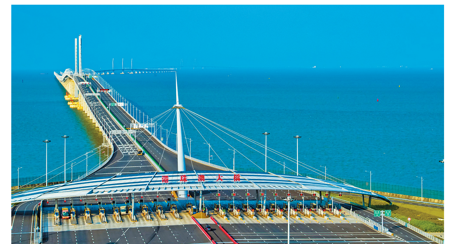
港珠澳大桥开通后,珠海成为全国唯一与港澳陆路相连的城市。
