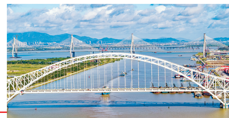
架设在马骊洲水道的横琴二桥。
