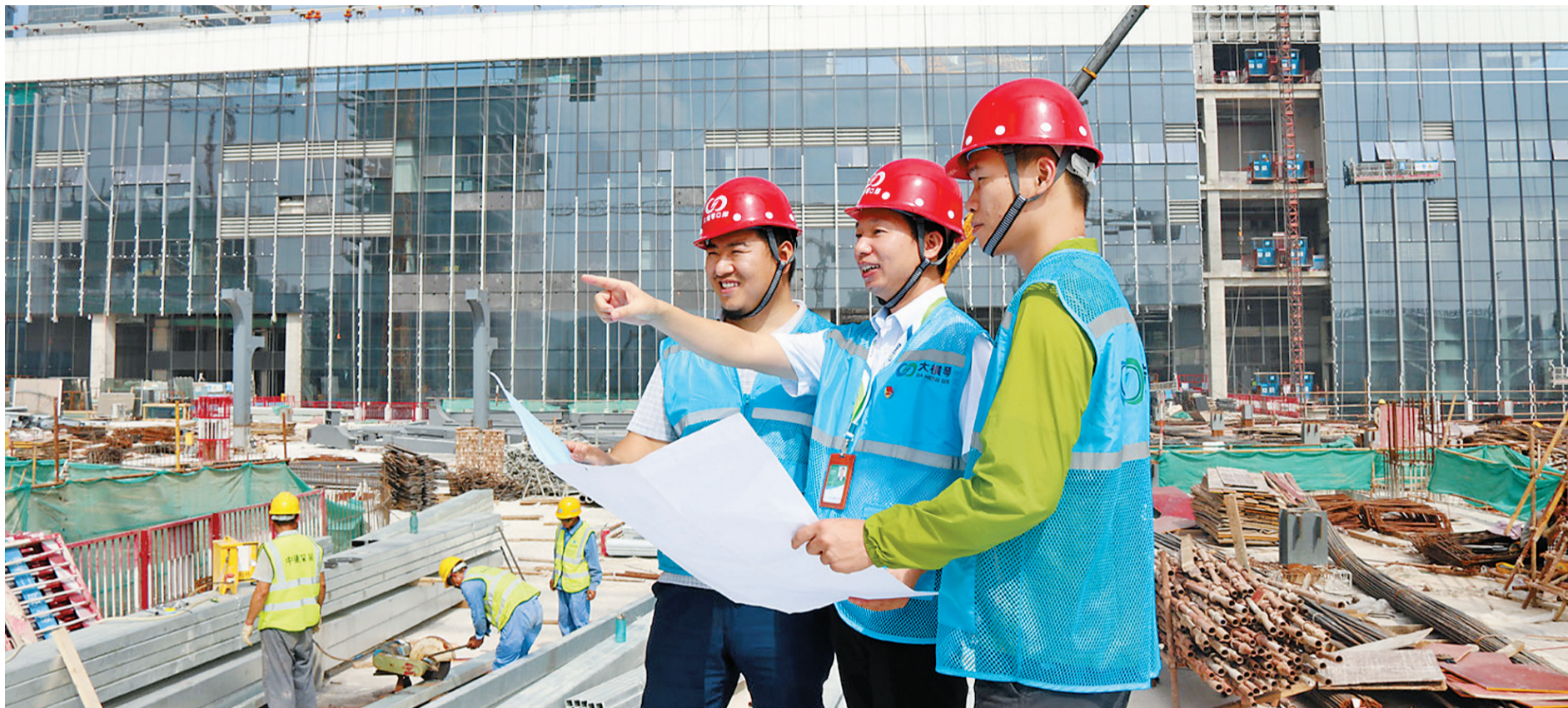
党员模范战斗在横琴口岸建设工地一线。
