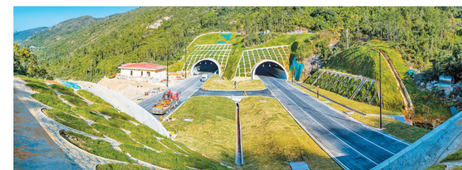
大横琴山隧道工程(一期)。
