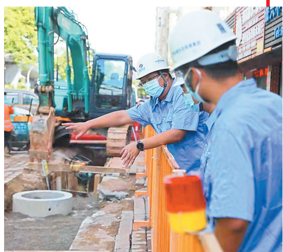
总承包部党支部检查正本清源小区施工现场。
