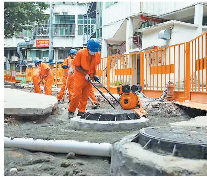
前山河项目正本清源小区施工。
