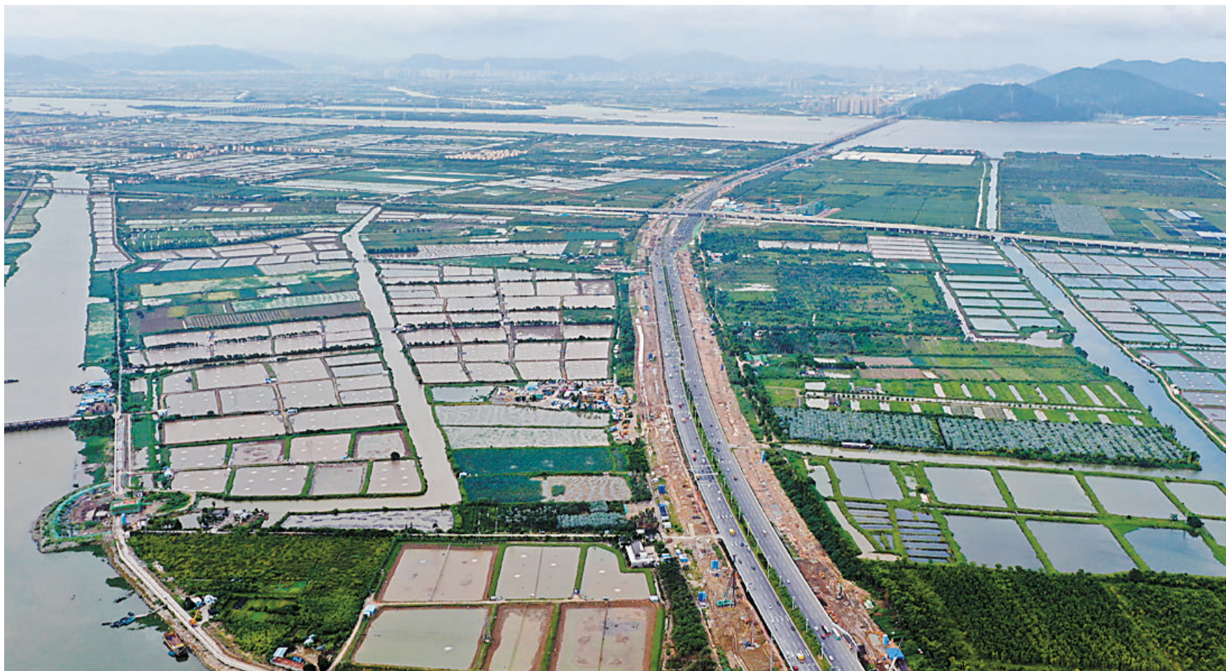
河网纵横的鹤洲片区。
