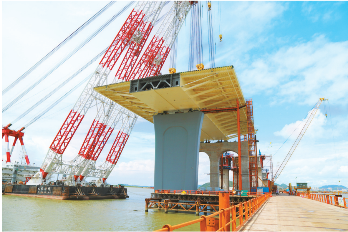
钢箱梁架设现场。
