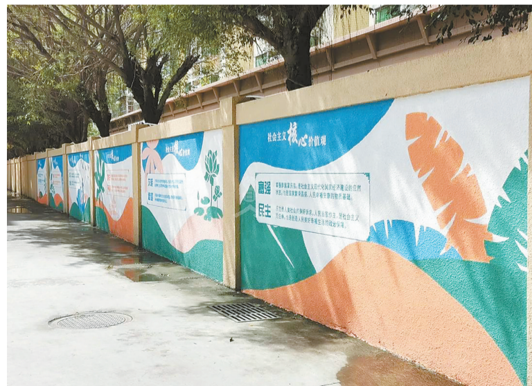
已建成14年的泰和苑小区面貌一新。 本报记者 张帆 摄
