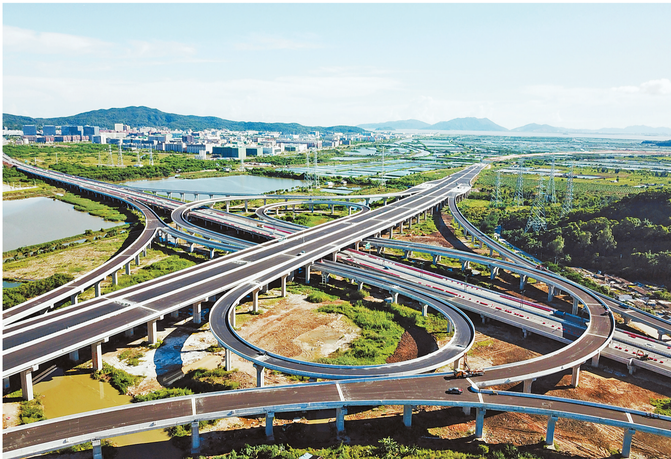
鹤港高速一期工程范围内沥青路面摊铺工作已顺利完成。 本报记者 曾遥 摄
