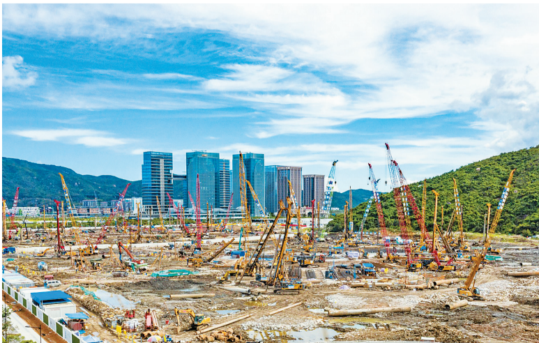
“澳门新街坊”项目建筑工地。
