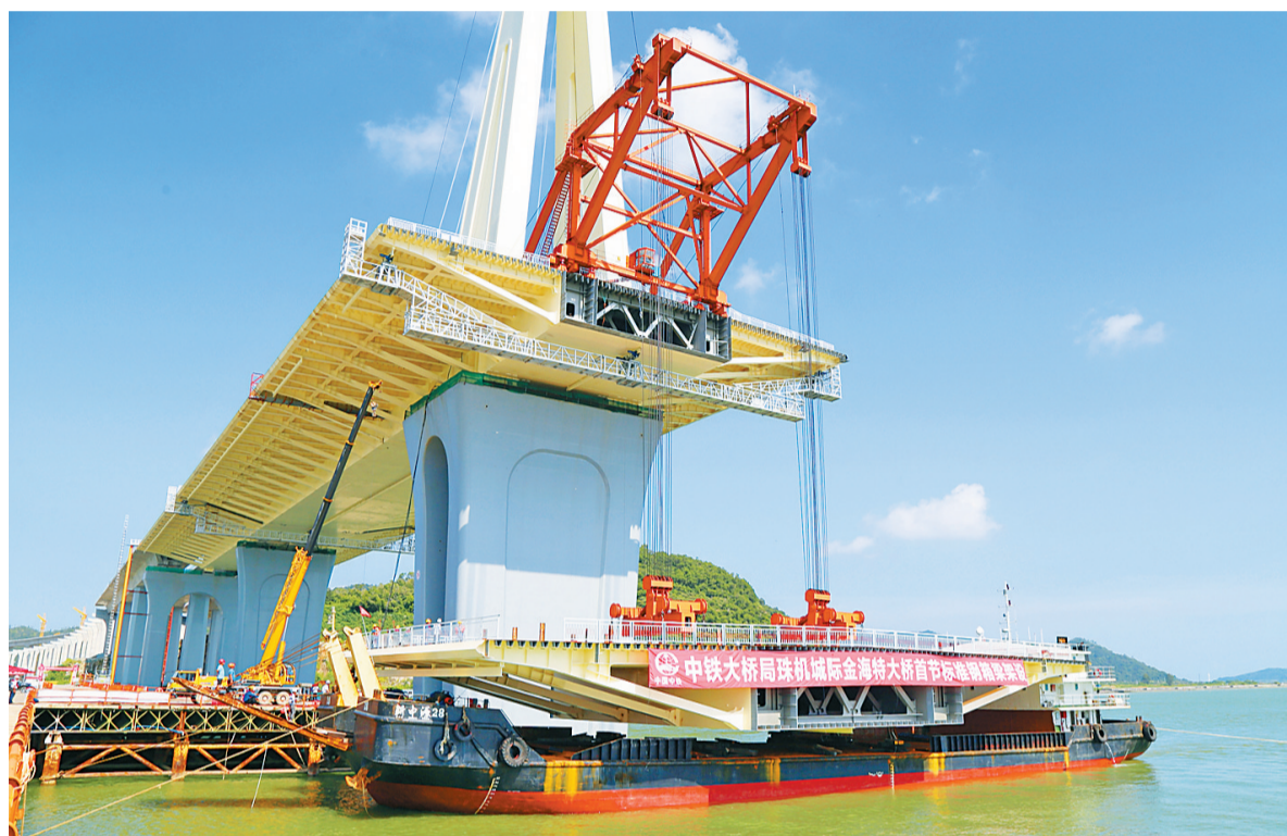
首节标准钢箱梁架设现场。
