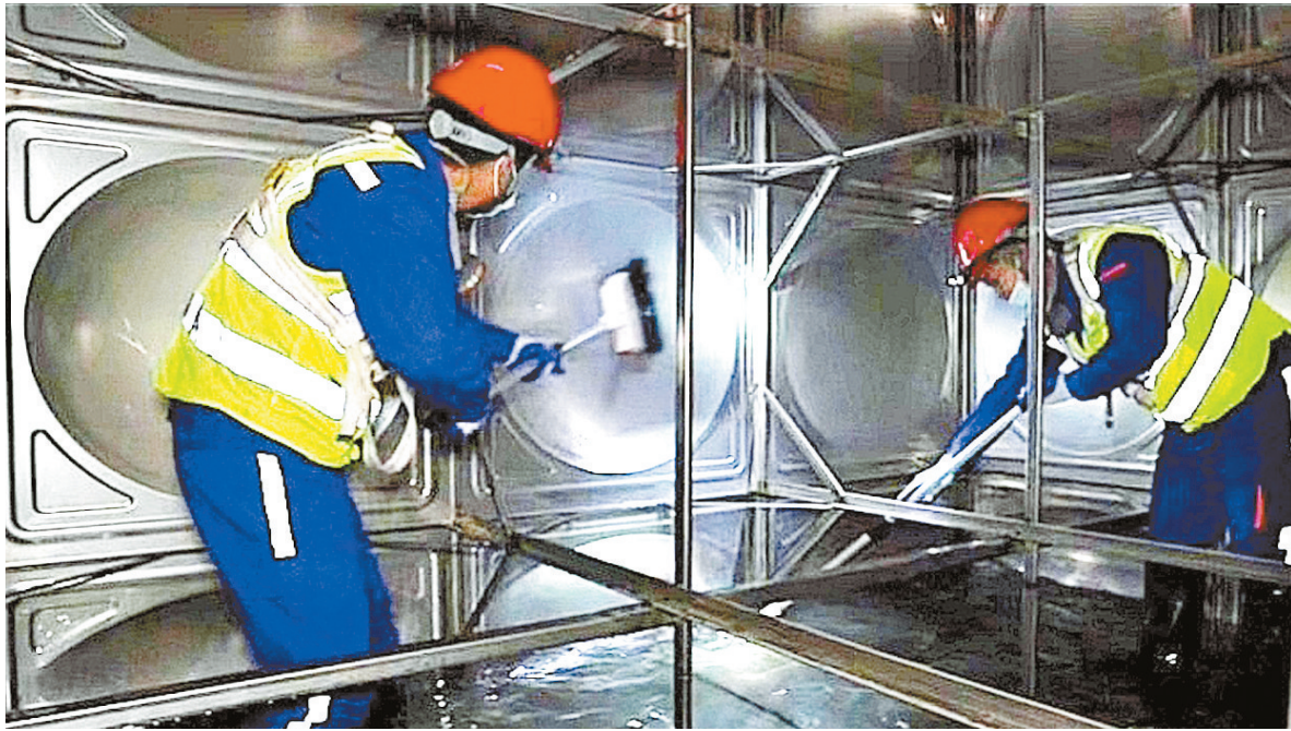
工作人员清洗水池。通讯员 张智慧 摄
