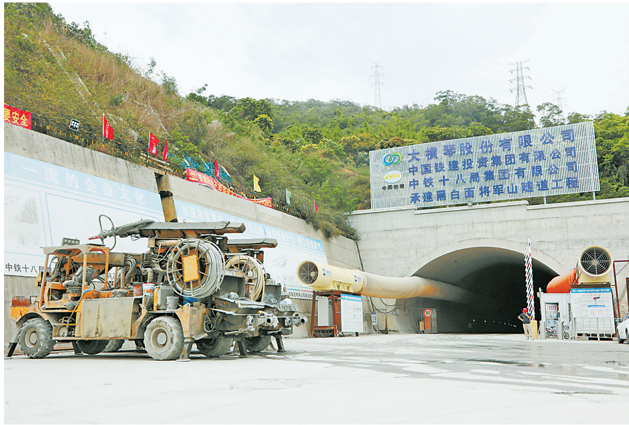
黑白面将军山隧道工程建设现场。本报记者 曾遥 摄
