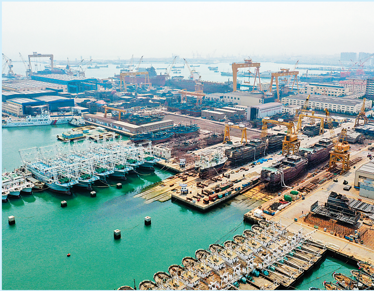
5月20日拍摄的黄海造船有限公司厂区(无人机照片)。当日,位于山东省威海市荣成市的黄海造船有限公司厂区一片繁忙景象,多艘大型船舶同时处在紧张建造中。2021年以来,黄海造船有限公司抓住国际市场变化,主动对接国内外各大航运公司,积极寻求新的市
