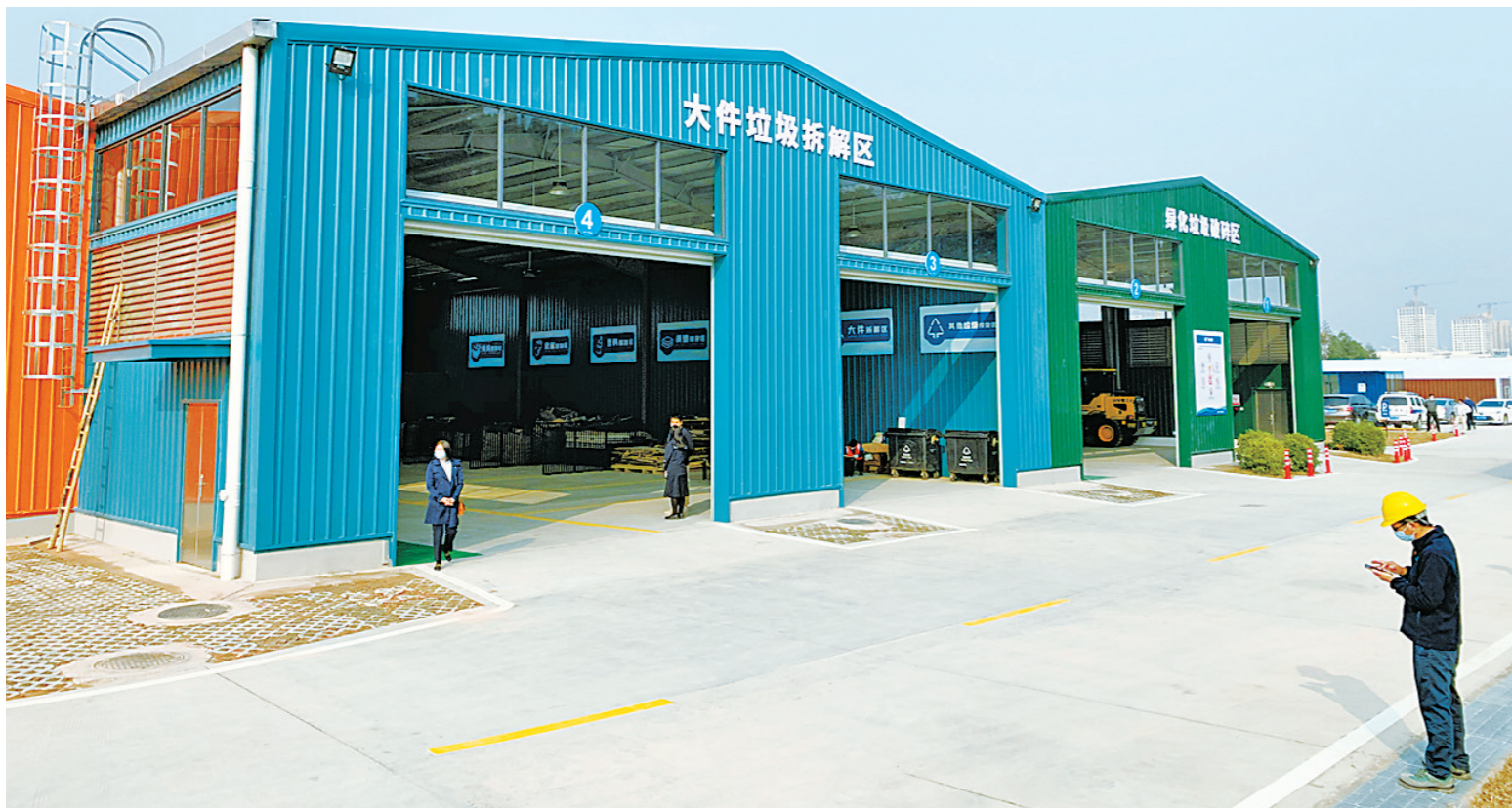
为完善全链条收运体系,横琴在琴海东路南侧建成1号垃圾压缩中转站,占地面积近1500平方米。该站点集生物工程、机电工程、环境工程技术于一体,处理规模为150吨/天。 本报记者 吴长赋 摄
