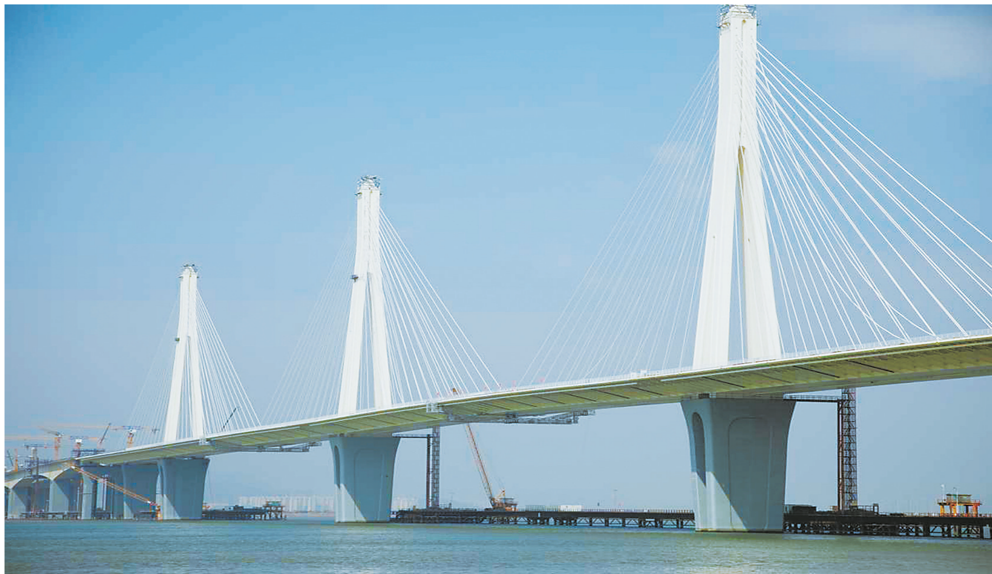
金海大桥的贯通进一步提升了横琴的区位优势。
