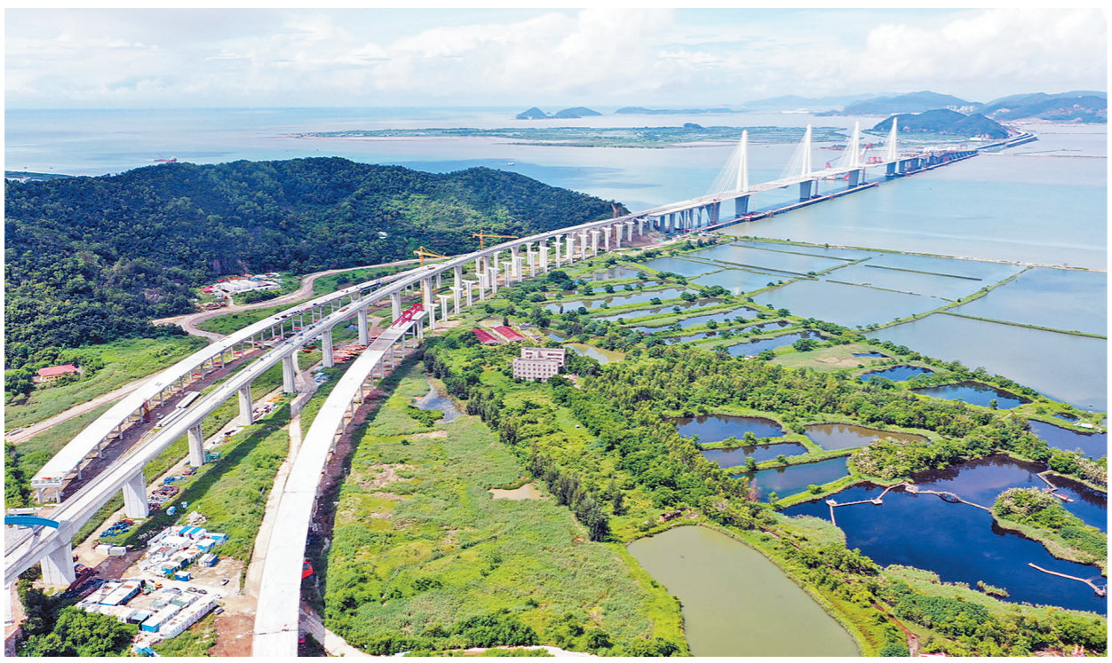
建设中的金海大桥。
