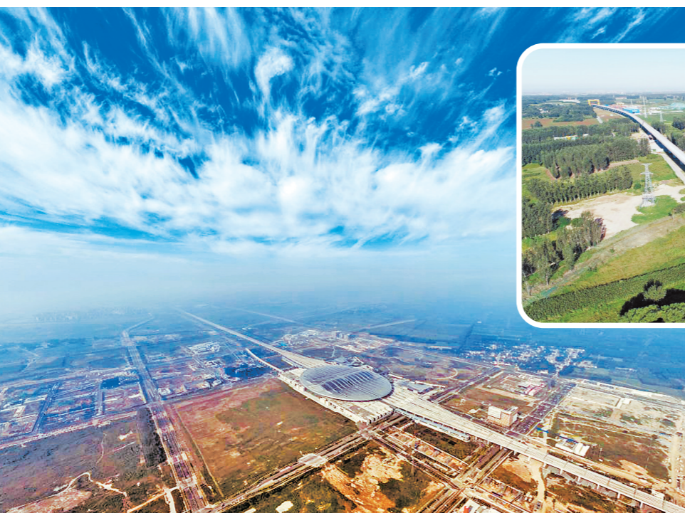
▲R1线地上工程施工现场。 受访者供图
