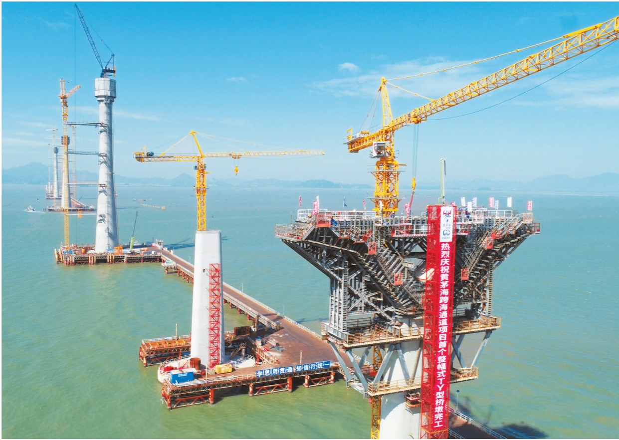
13日上午,黄茅海跨海通道项目首个整幅式TY型桥墩完工。 本报记者 李建荣 摄
