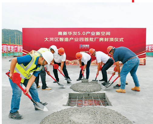
9月27日,高新区的大湾区智造产业园首批厂房封顶。
