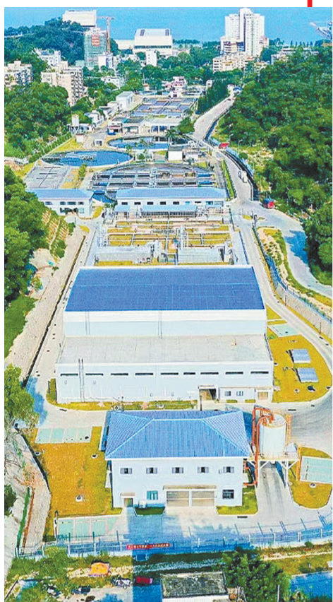
香洲水质净化厂三期项目。
