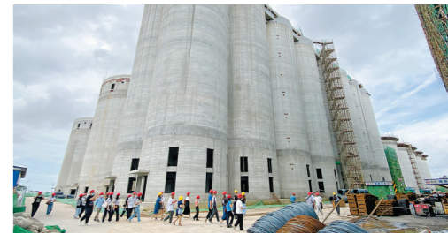
珠海中心粮库二期(在建)。
