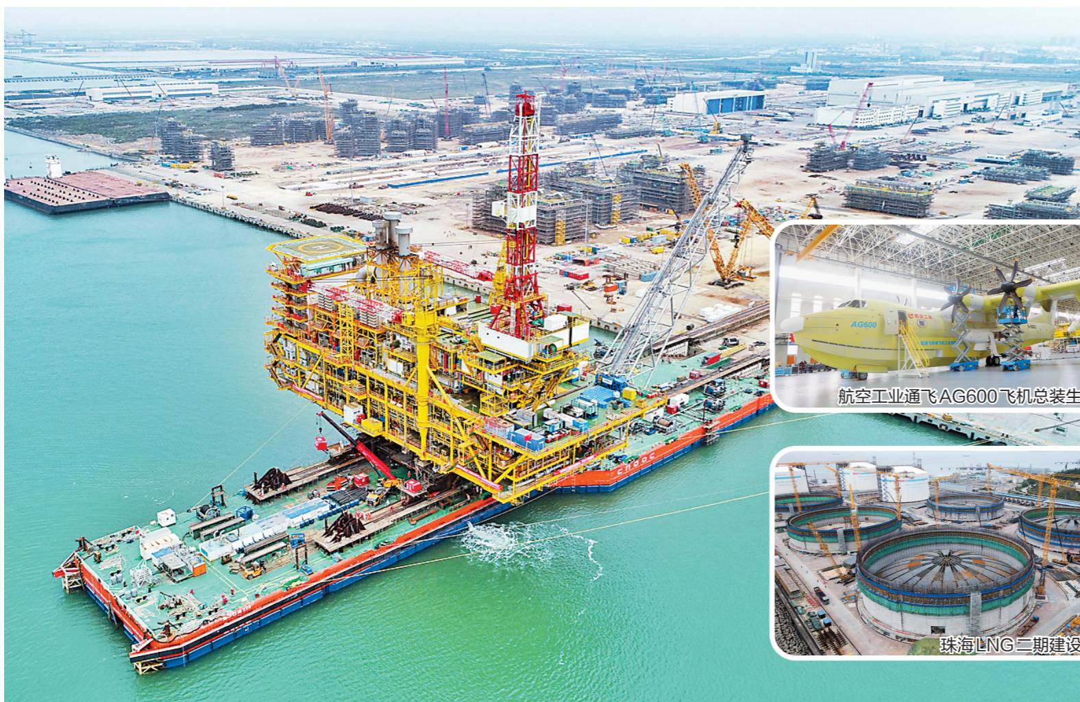
中海福陆项目现场。
