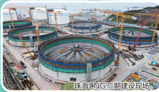
珠海LNG二期建设现场。
