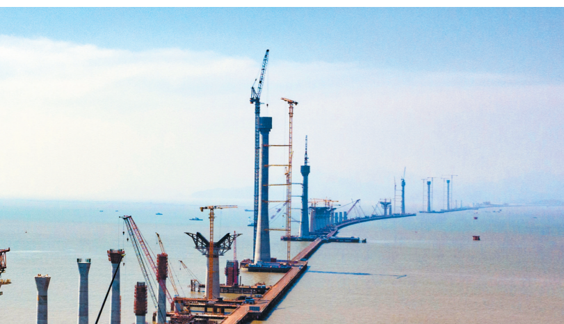
黄茅海跨海通道高栏港大桥东主塔施工现场。
