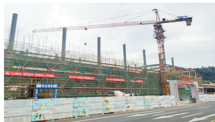
珠机城际二期三灶东站施工现场。
