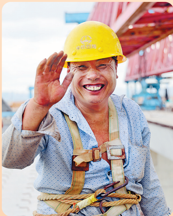
香海大桥的建设者抢赶工期。
