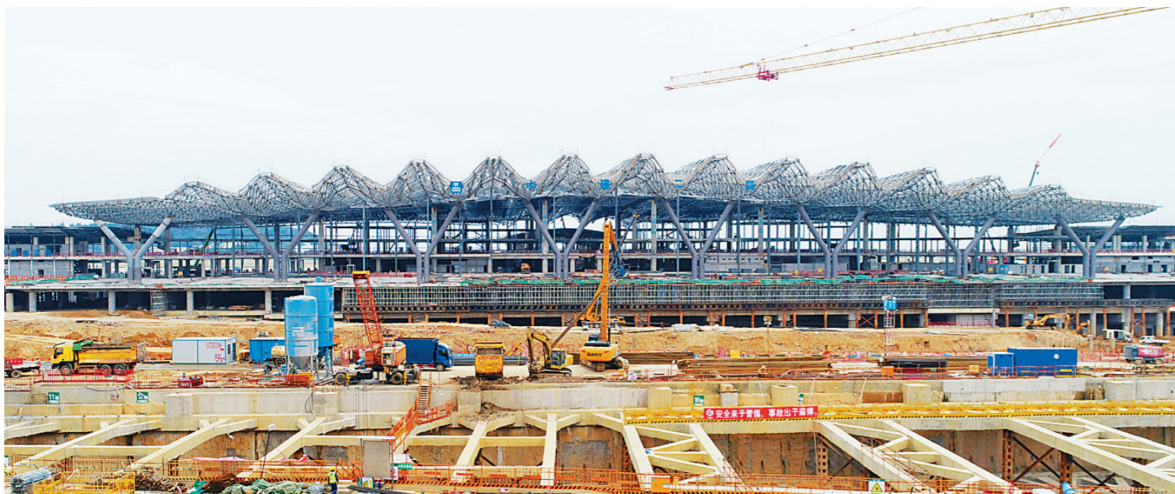
10月20日,珠海机场改扩建工程现场,新建T2航站楼已展开“湾区之翼”。
