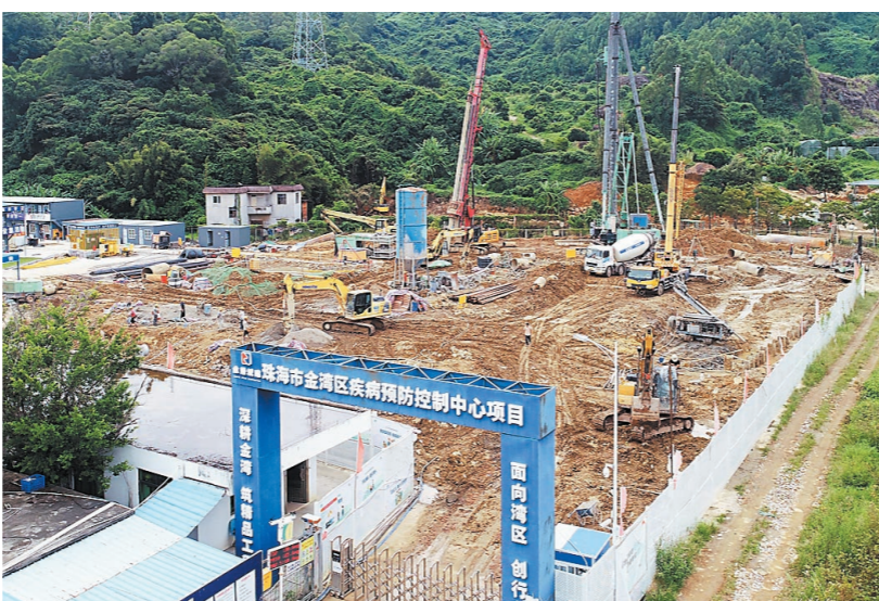
金湾区疾病预防控制中心建设现场。
