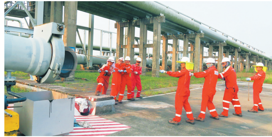
海管通球作业现场。 本报记者 张洲 摄
