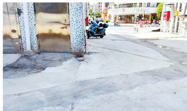
施工后地面干净整洁。本报记者 张洲 摄
