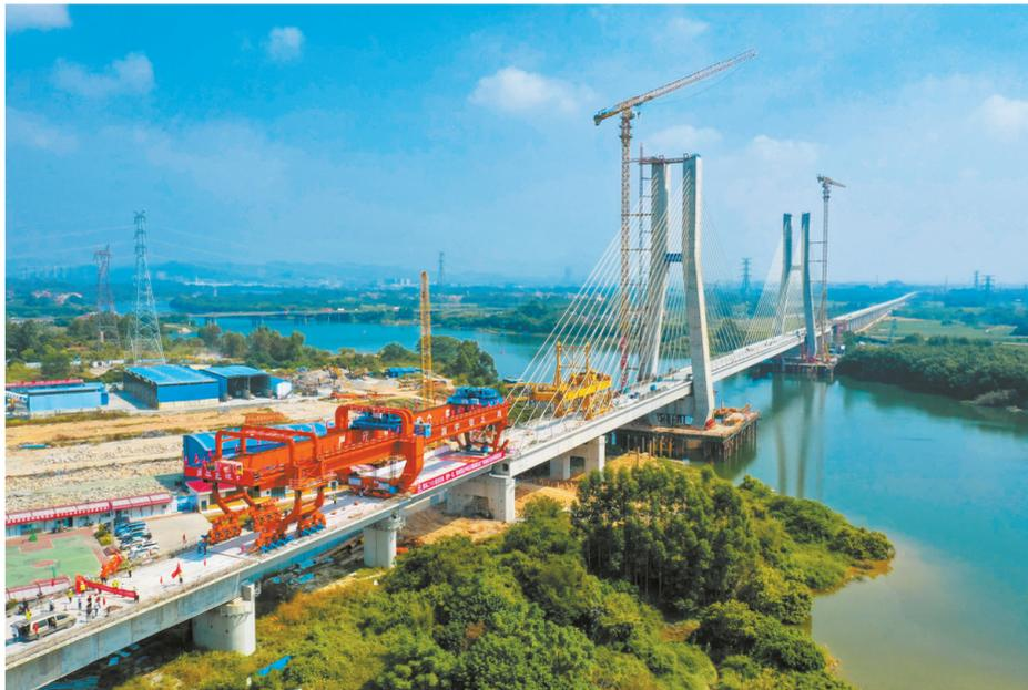
10月25日,施工人员操作架桥机将最后一孔900吨箱梁成功架设在增江特大桥桥墩上(无人机照片)。
