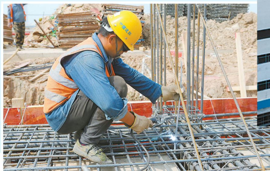
如火如荼的建设现场。
