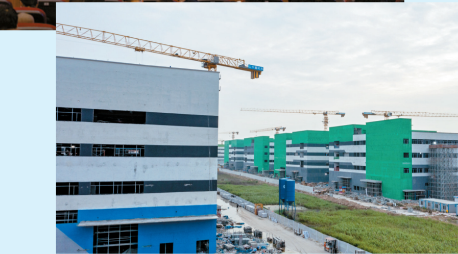
富山工业城5.0产业新空间建设。
