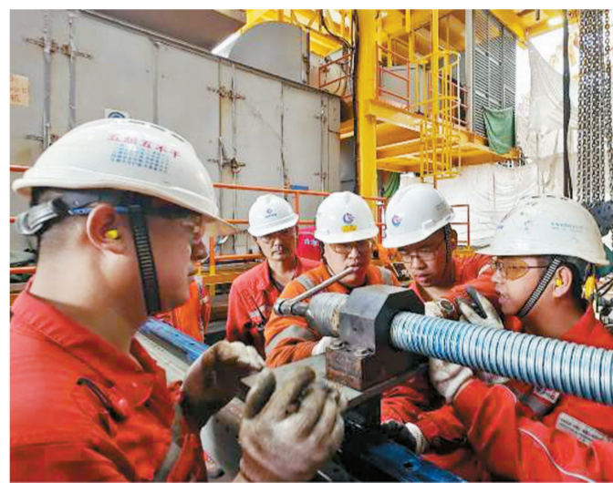
技术攻关团队在进行置换作业。
