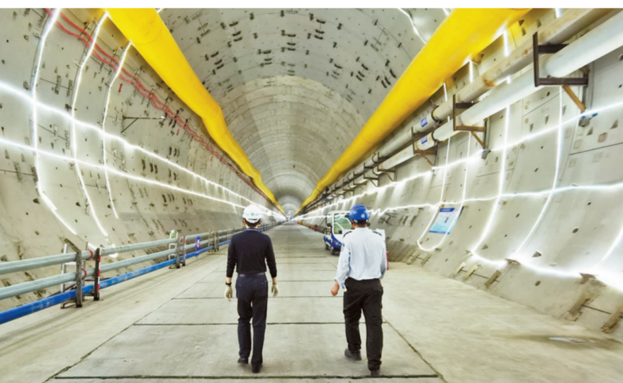
检查组深入盾构机隧道掘进现场开展检查工作。本报记者 吴长赋 通讯员 罗洁琼 摄
