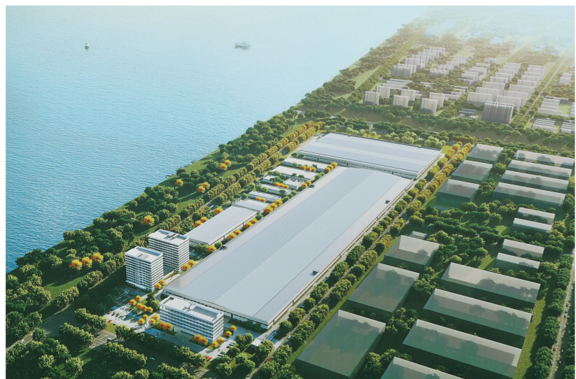
鸿钧异质结新型高效太阳能电池项目效果图。本报记者 梁冠贤 摄
