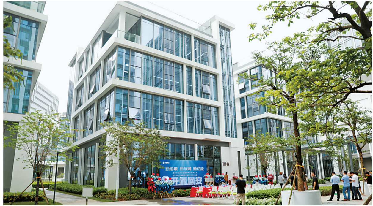
软件供应链安全检测中心、网安基地培训中心珠海分中心在高新区同时成立。 本报记者 吴长赋 摄
