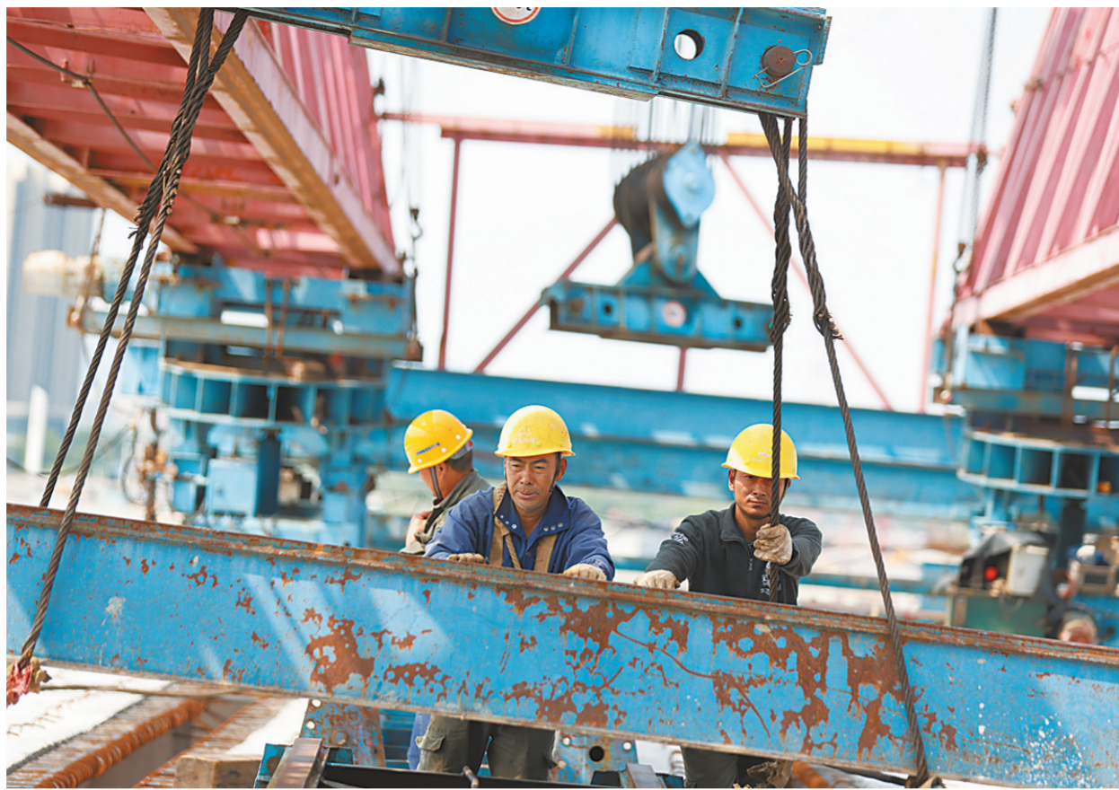
施工工人正在香海大桥西延线施工。 本报记者 李建束 摄
