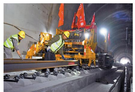
5月22日,中铁一局建设者在金甬 铁路楼胜隧道内进行铺轨作业。
