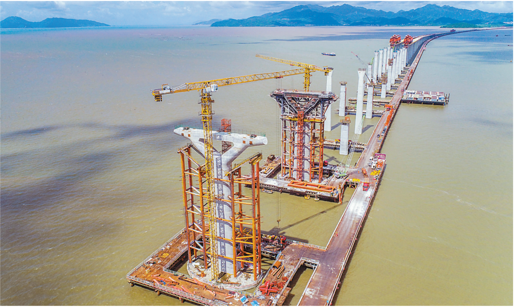
黄茅海跨海通道项目整幅式TY型桥墩全部完工。
