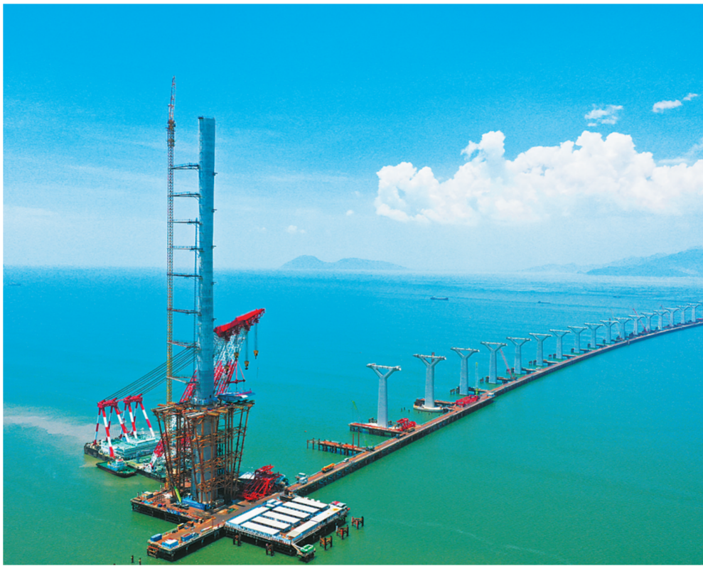
▲黄茅海跨海通道施工现场。受访单位供图
