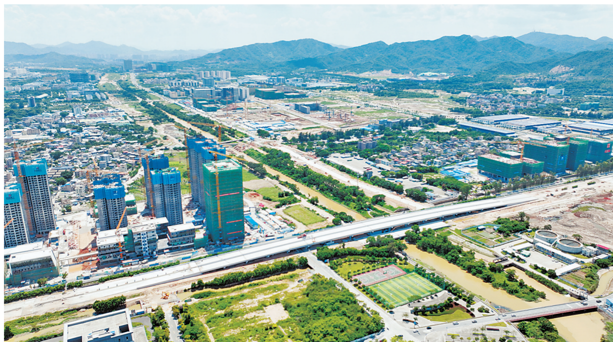
已完成主体结构的中珠渠桥梁主桥。本报记者 陈新年 摄
