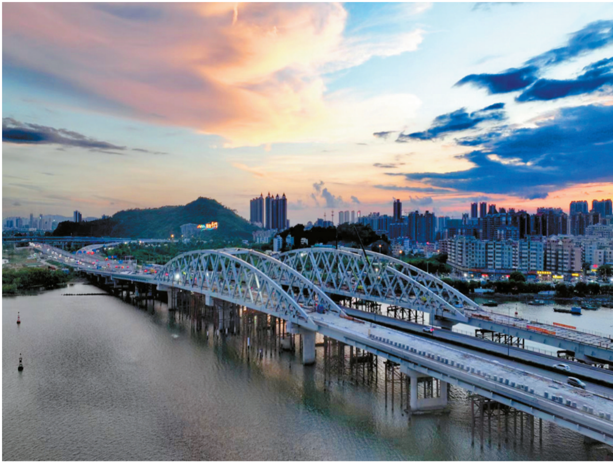
泥湾门辅道桥已经全线贯通,正在进行拱架焊接。
