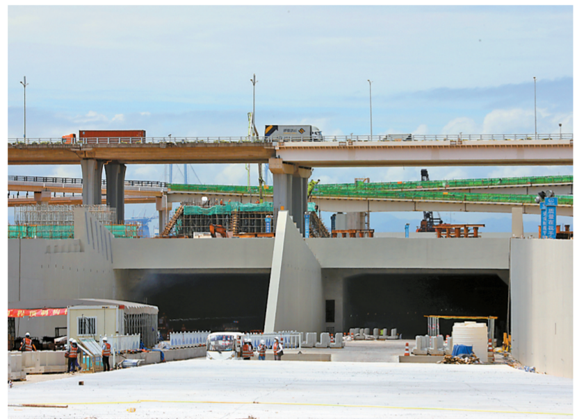
广深沿江高速横跨深中通道东人工岛,岛上主隧道穿越高架桥53#和54#桥墩。 本报记者 程霖 摄
