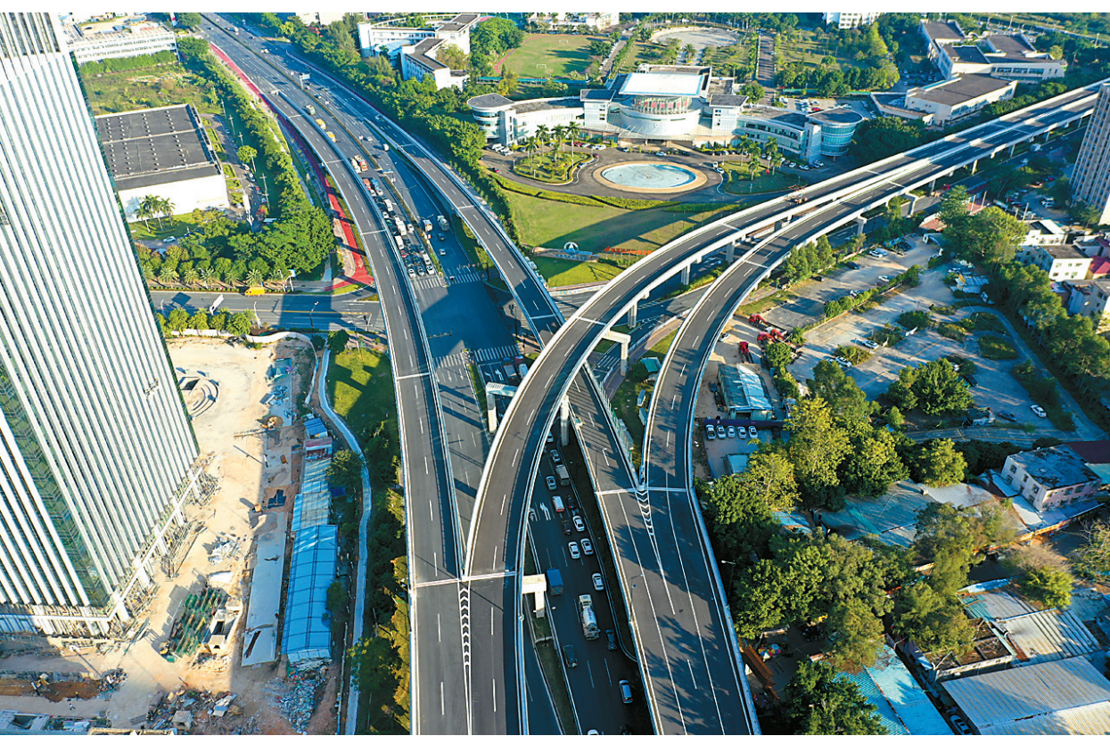
高新互通所有建设项目均已完工。珠海交通集团路泓工程管理有限公司供图
