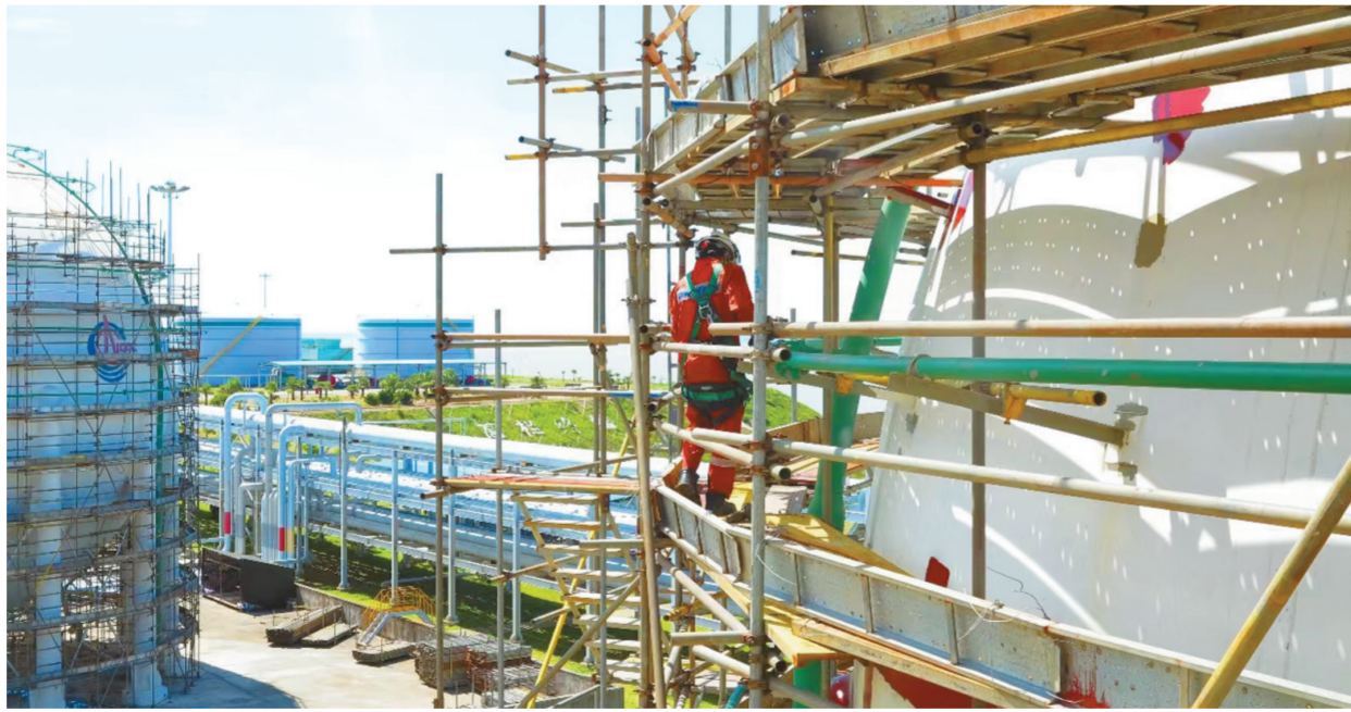
工作人员对球罐进行检测。 中海油高栏终端供图
