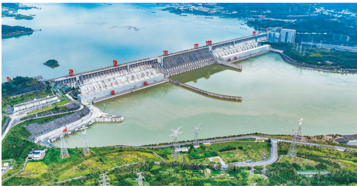
受近期长江流域持续性强降雨过程影响,三峡入库流量随之升高。中国三峡集团数据显示,9月26日2时15分,三峡电站总出力达2250万千瓦,实现2023年首次满负荷运行。
