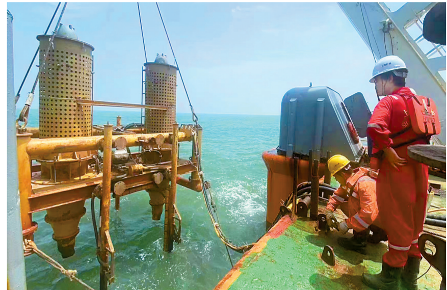
项目施工人员假期施工。本报记者 曾遥 通讯员 张俊山 摄
