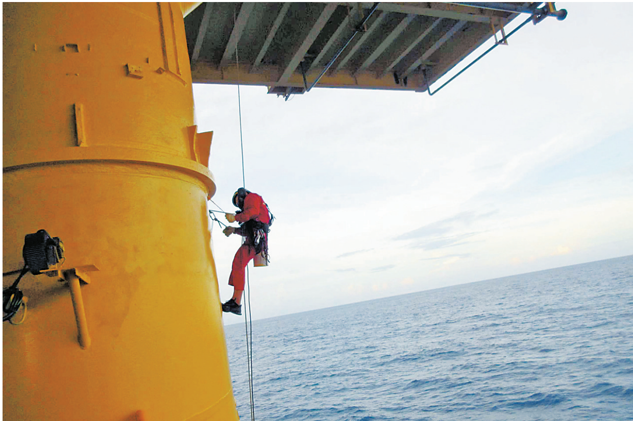
技术人员利用绳索在番禺30-1平台开展高空检测作业。中国海洋石油白云天然气作业公司供图
