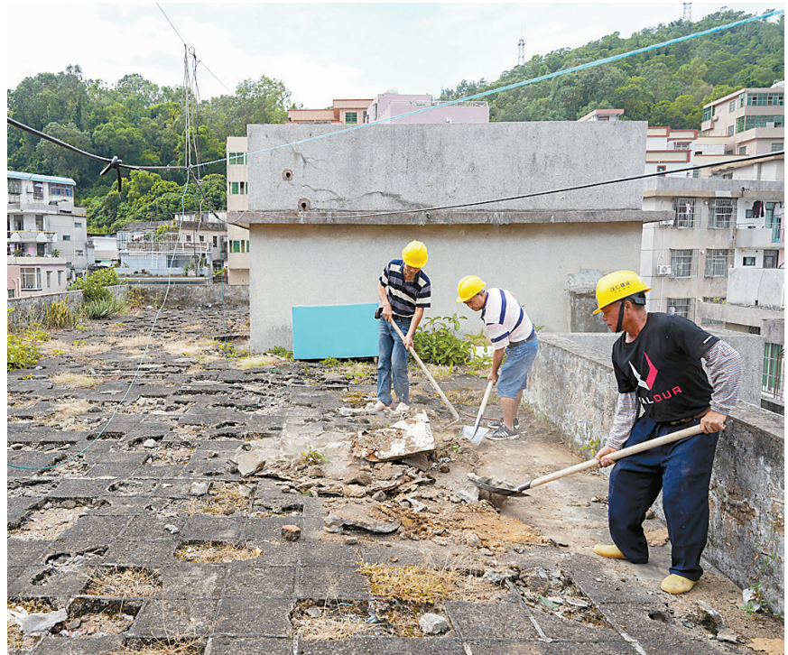
施工现场。本报记者 赵梓 摄
