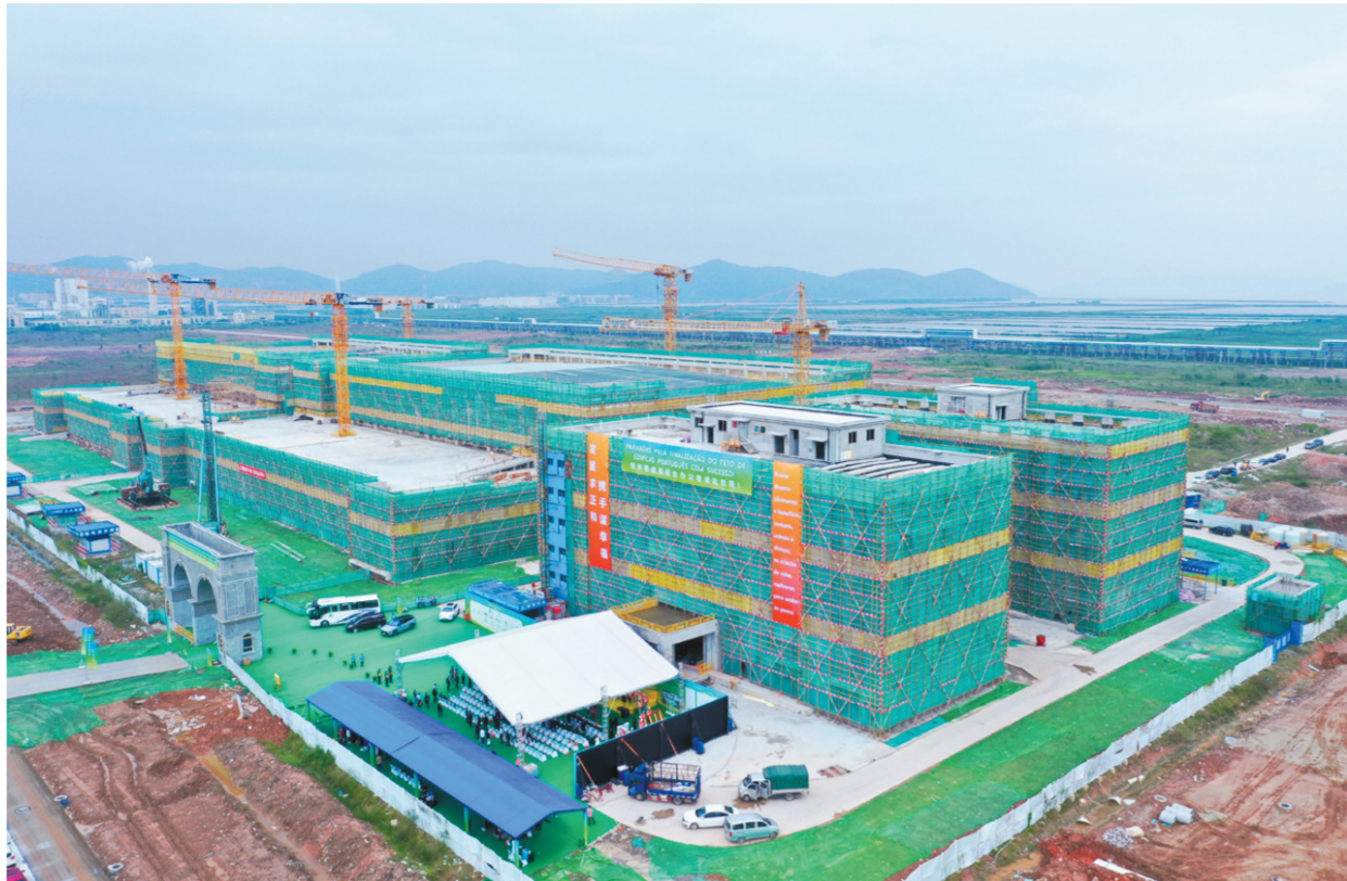
“中国-拉美经贸一体化服务平台”葡语系综合办公楼封顶。 本报记者 梁冠贤 摄
